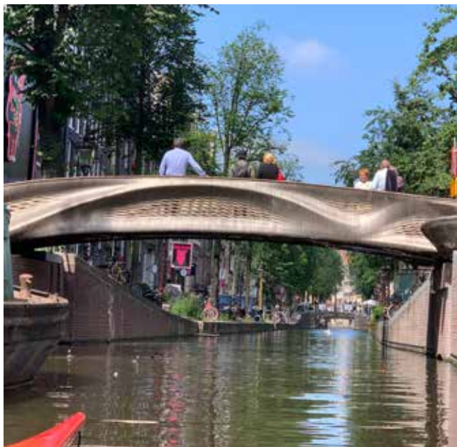
Stoofbrug in Amsterdam, een 3d-geprinte brug, Bron Wikipedia
